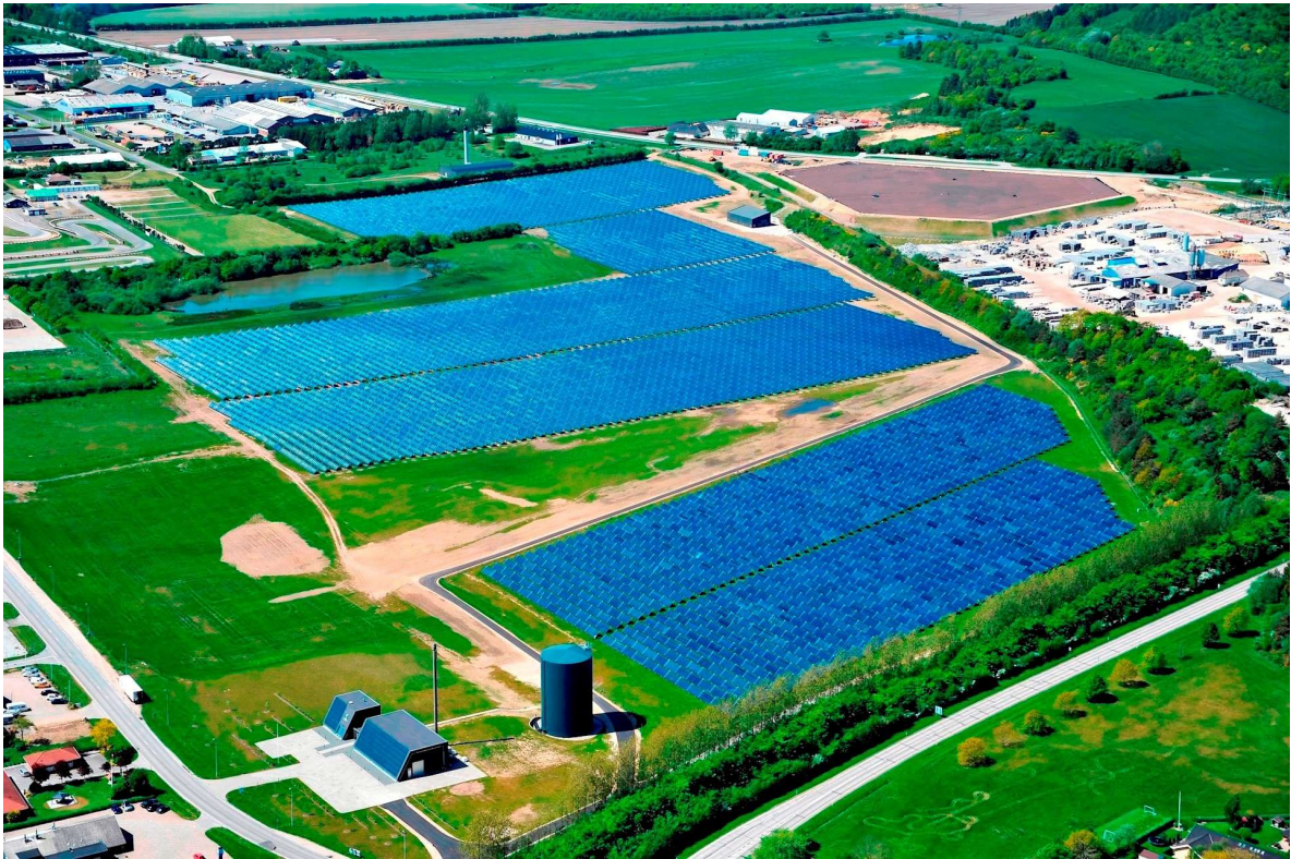
Abb. 22: Solarthermieranlage mit rd. 200.000 m 3 Erdbeckenwärmespeicher (Wärmespeicher oben rechts im Bild/ Bild: www.vojensfjernvarme.dk )
