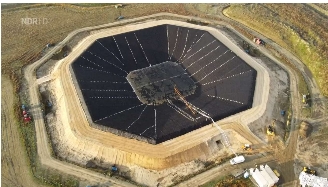
Abb. 23: Bau Erdbeckenwärmespeicher Meldorf mit rd. 43.000 m 3 (Bild: www.ramboll.com )
