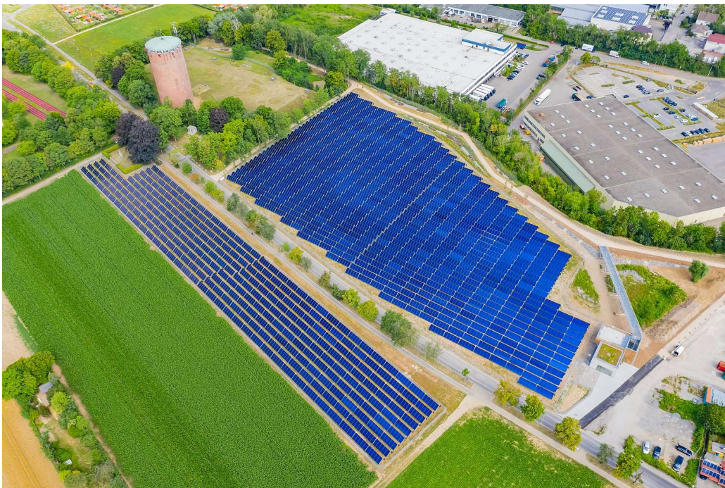
Abb. 21: Solarthermieranlage auf Ludwigsburger und Kornwestheimer Gemarkung (Quelle: SWLB)
