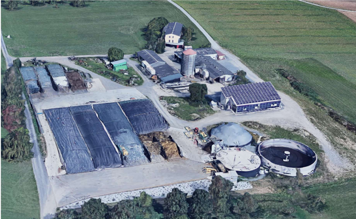
Abb. 27: Biogas-BHKW Schertlenswaldhof (Bildquelle: Google Maps)
